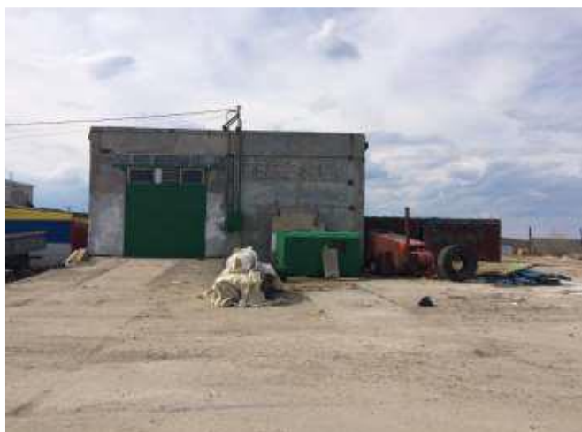
Здание склада холодного «Оборудование», инв. № 2422
