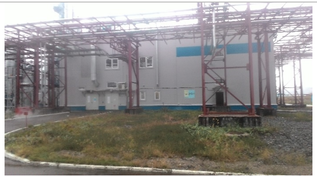
Общий вид зданий и сооружений.
