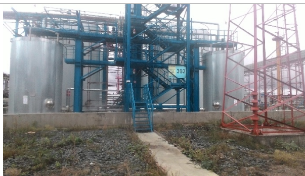
Общий вид зданий и сооружений.
