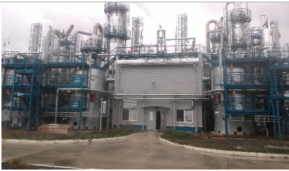
Общий вид зданий и сооружений.
