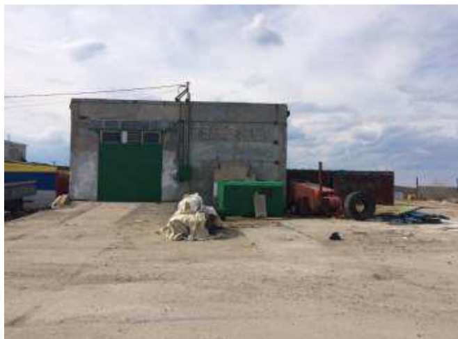
Здание склада холодного «Оборудование», инв. № 2422
