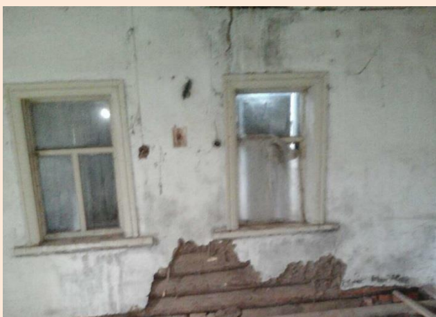
Фото 3. Внутреннее состояние жилого дома
