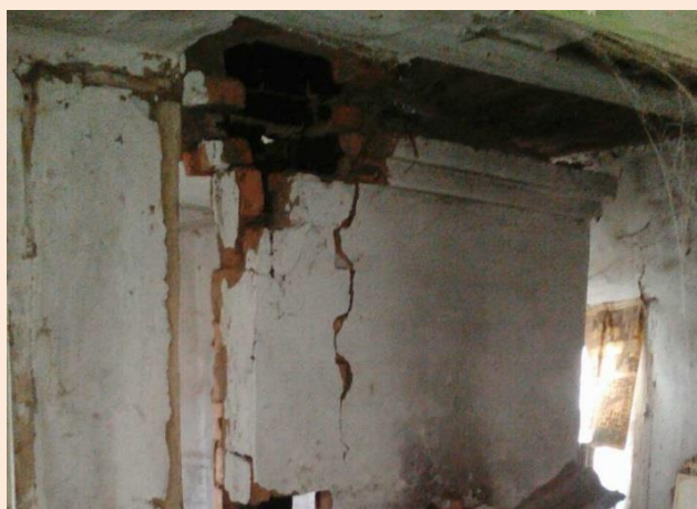
Фото 4. Внутреннее состояние жилого дома
